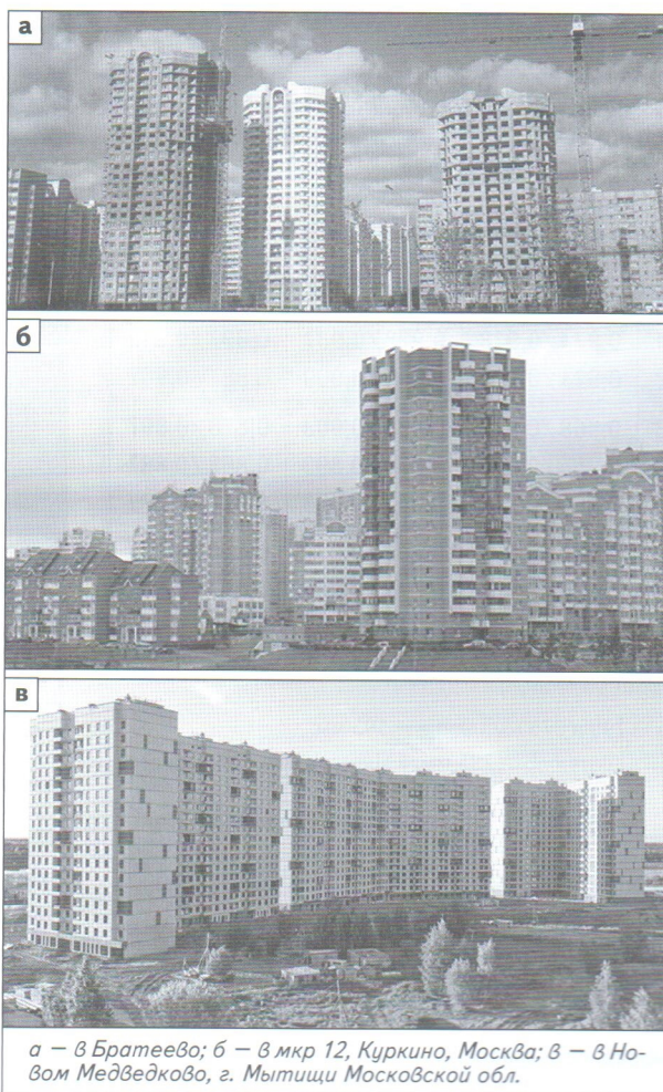
Рис. 8. Многоэтажные дома со стенами из сплошных полистиролбетонных блоков
