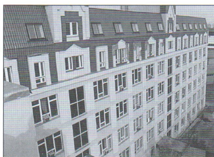
Рис. 6. Мансардная надстройка из полистиролбетонных блоков и плит над зданием института «ВНИИжелезобетон» (без усиления фундаментов), Москва
