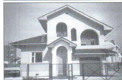
Рис. 7. Первых два коттеджа с полистиролбетонными стенами с внутренней бетонной решеткой из перекрестно-пустотных элементов в Жулебино, Москва
