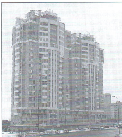
Рис. 9. Жилые дома из монолитного полистиролбетона в Куркино, Москва
