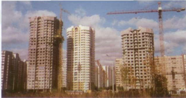
Панорама строительства многоэтажных жилых зданий в районе Братеево, г. Москва
