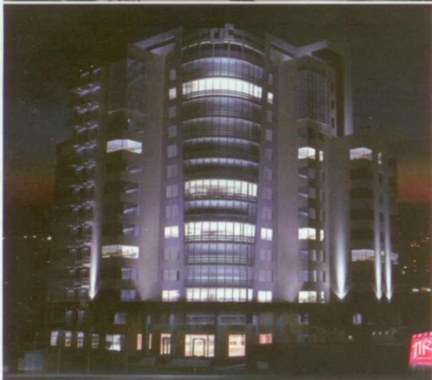
14-этажное здание бизнес-центра в районе Перово, г. Москва
