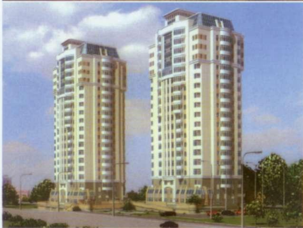
18-этажные жилые здания из монолитного полистиролбетона в районе Куркино, г. Москва
