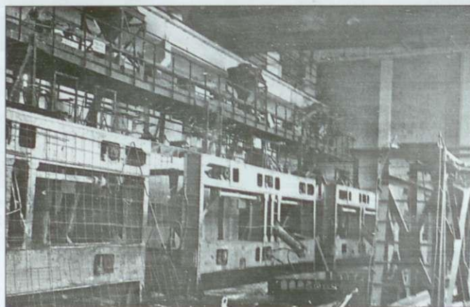
Рис. 2. Кассетные установки в пролёте завода ЖБИ
