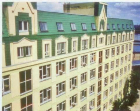
Здание ВНИИ-железобетон (Москва) с надстроенной мансардой, утепленной полистиролбетоном
