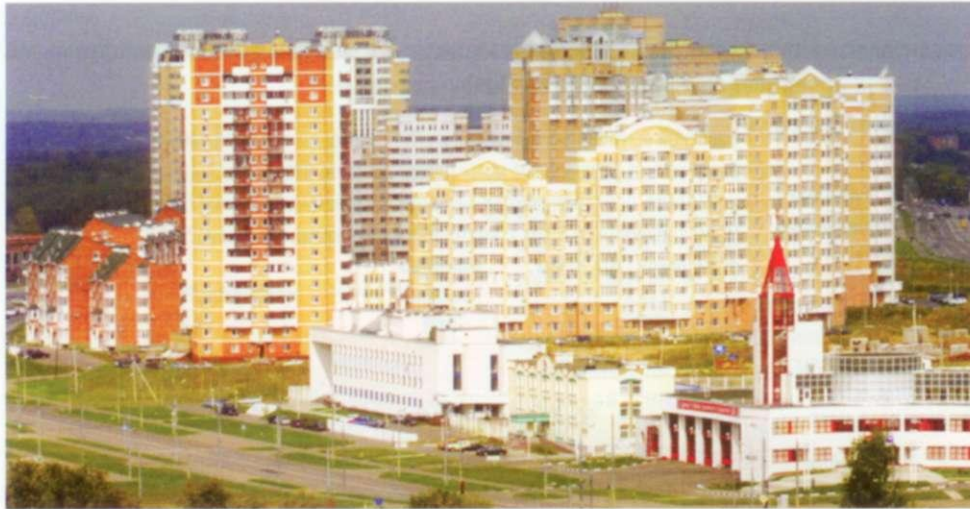
Куркино, микрорайон № 12 Комплекс зданий
